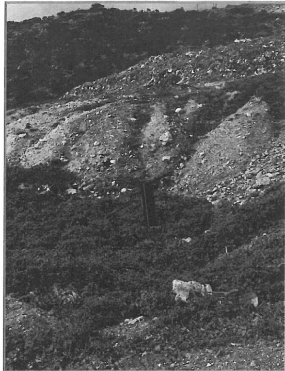
Εικόνα 4: Σωλήνας απαγωγής βιοαερίου από HDPE στο ΧΥΤΑ Χερσονήσου
