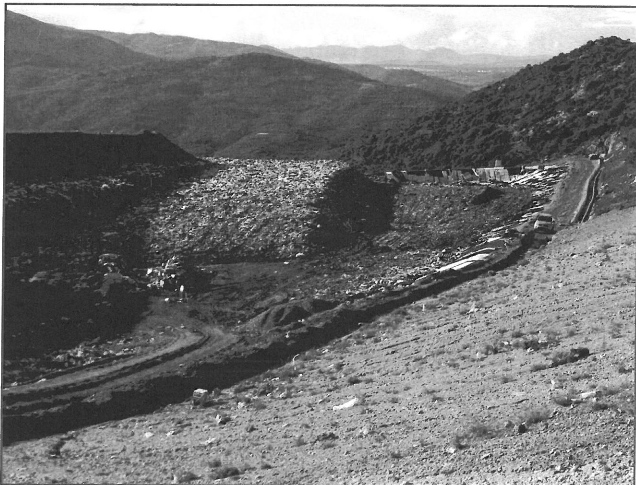
Εικόνα 2: Χώρος εναπόθεσης απορριμμάτων κατά τη χρον. περίοδο από 4/2019 - περιοχή τοποθέτησης συστήματος απαγωγής βιοαερίου.
